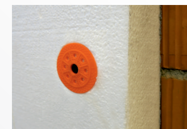
4 Poprawnie zamontowany tącznik izolacji
