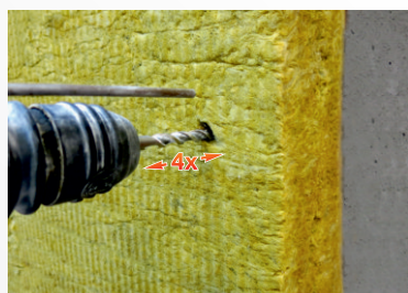
1 Wywiercić otwór w murze używając udaru i dokładnie usunąć urobek
