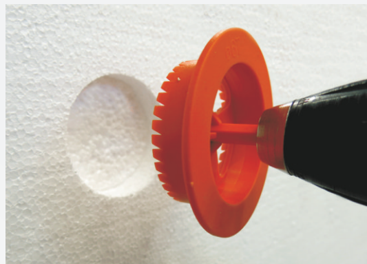
i Frezowanie otworu w styropianie
