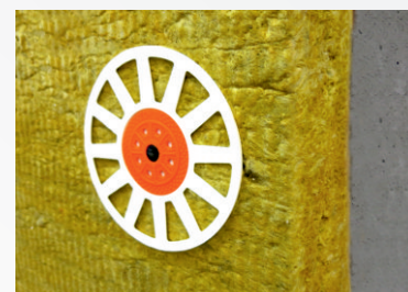
4 Poprawnie zamontowany tącznik izolacji
