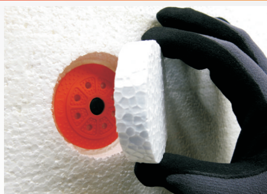
i Zaślepianie otworu za pomocą zaślepki
