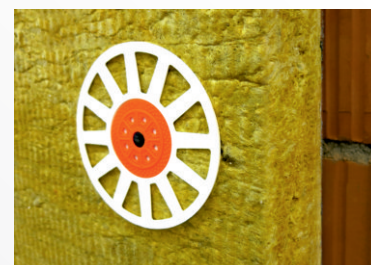
4 Poprawnie zamontowany tącznik izolacji
