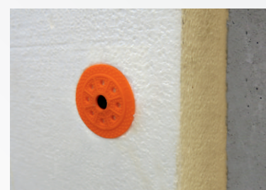
4 Poprawnie zamontowany tącznik izolacji
